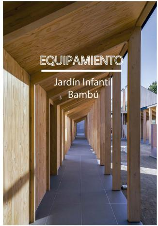
La estructura de los corredores se compone de pilares y vigas de madera laminada impregnada, con placa contrachapada para la cubierta.
